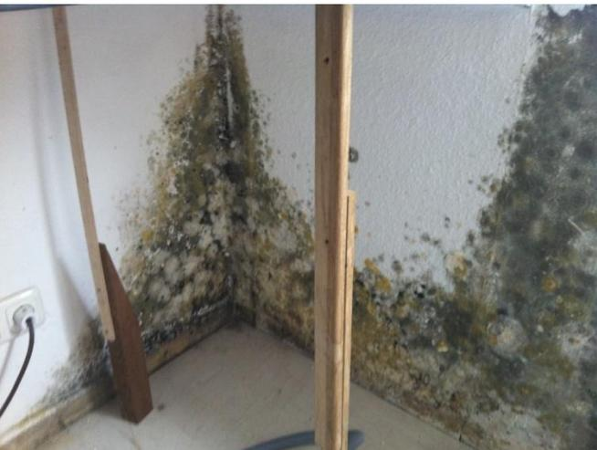
Massiver Schimmelschaden hinter einer ausgebauten Küchenzeile
