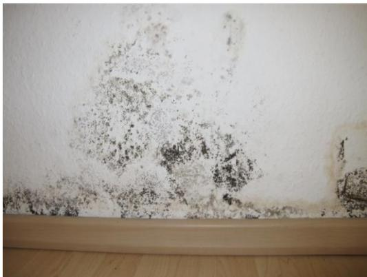
Häufiges Bild: Schimmelpilzbefall einer Wandfläche im Bereich der Fußleiste.
